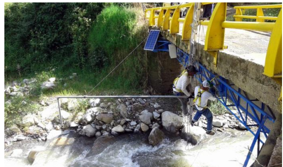
Εικόνα 2:Εγκατάσταση ηλιακών αισθητήρων Plug&Sense
